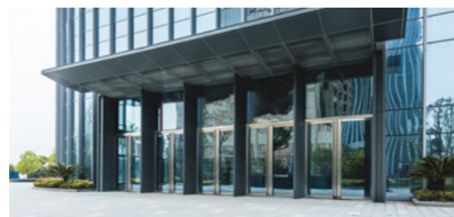
Realizzazione di infissi e facciate
